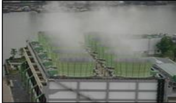
รูปที่ ค-5 การติดตั้งอุปกรณ์ครอบมอเตอร์ขับใบพัด (Cooling Fan Motor) และเพิ่มโครงสร้างเพื่อยึดปล่องใบพัด (Fan Stack) เพื่อลดเสียงที่เกิดจากหอหล่อเย็น
