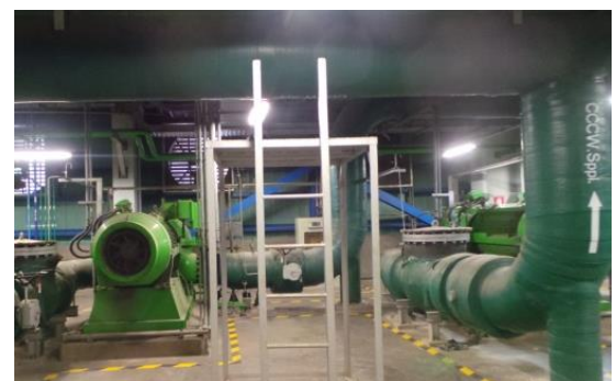
รูปที่ ค-3 การหล่อหุ้มระบบหล่อเย็นแบบปิด (Closed Cycle Cooling Water System) ด้วย Absorber เพื่อลดระดับเสียง
